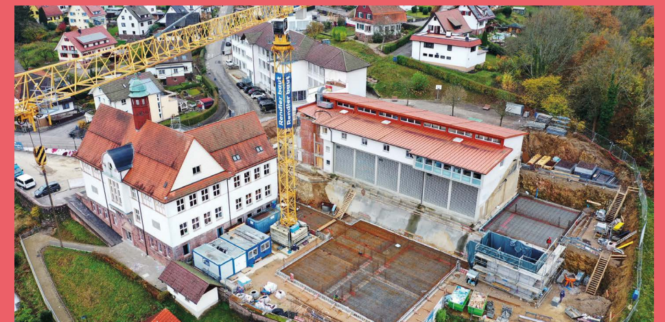
Betonieren der Bodenplatte am 11.11.2020
