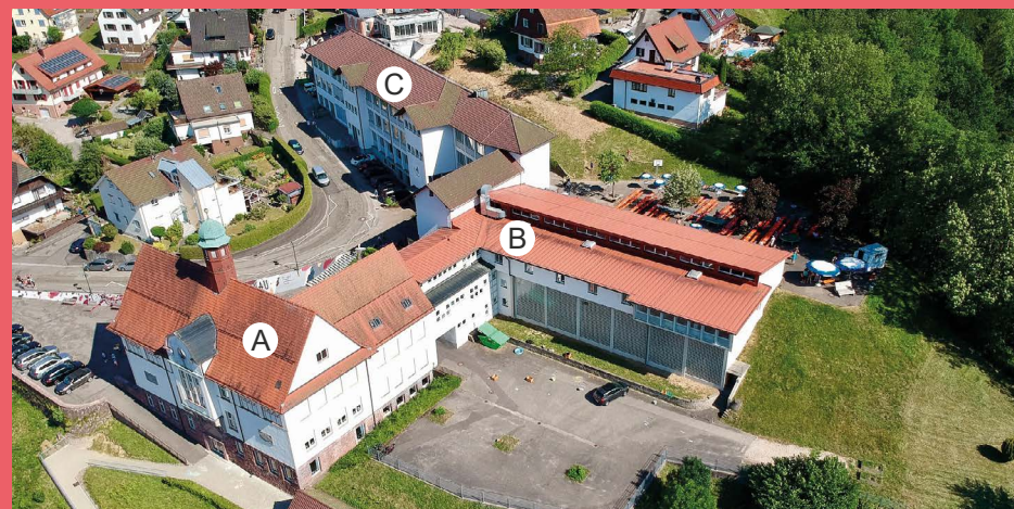
Franz-Rapp-Schule vor dem Umbau
