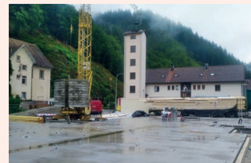
Übergabe der Bodenplatte an den Zimmermann
