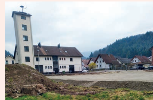
Beginn der Tiefbau- und Gründungsarbeiten
