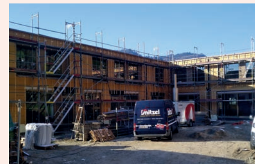
Beginn des Innenausbaus
