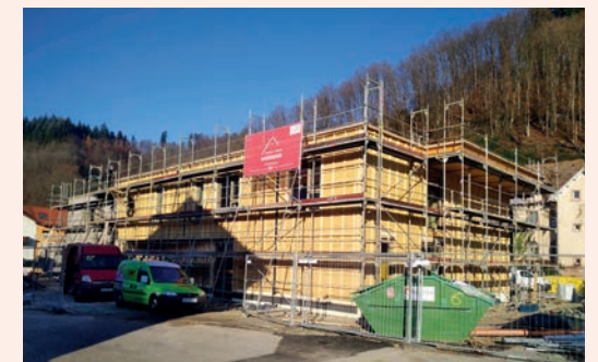
Bodenbelagsarbeiten, Fliesenarbeiten, Malerarbeiten, Fassadenarbeiten, Deckenarbeiten
